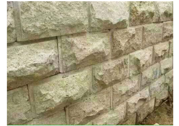
中岸錆 コブ出し
